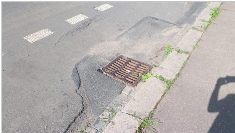
20-Trhliny opravy vozovky u odvodňovačů.jpg
