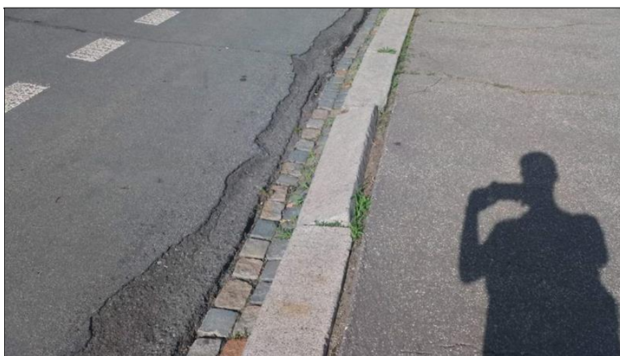
17-Vykloněný obrubník u chodníku vlevo.jpg
