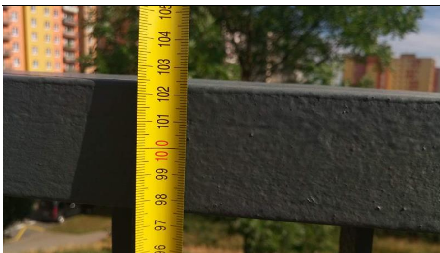
14-Výška zábradlí menší než 11 m.jpg
