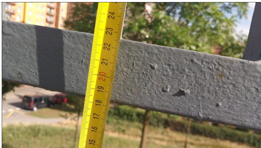
15-Výška dolní mezery zábradlí 180 mm.jpg
