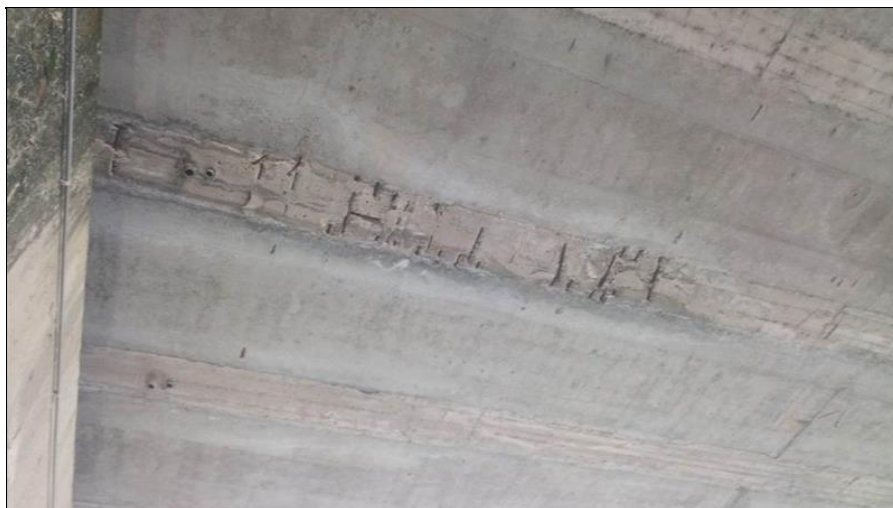
12-Stopy po zatékání do NK.jpg
