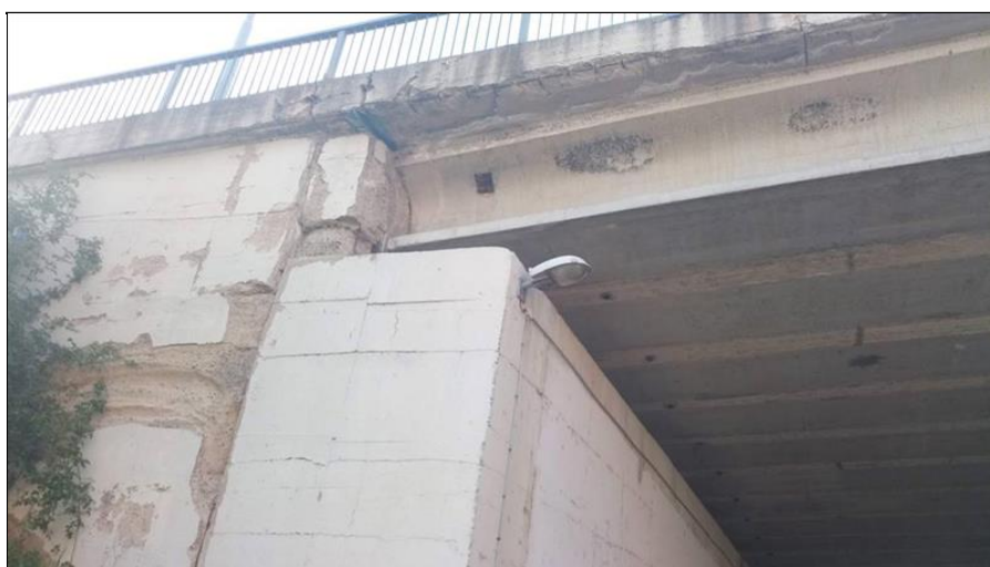
11-Zatékání na opěry a na NK.jpg
