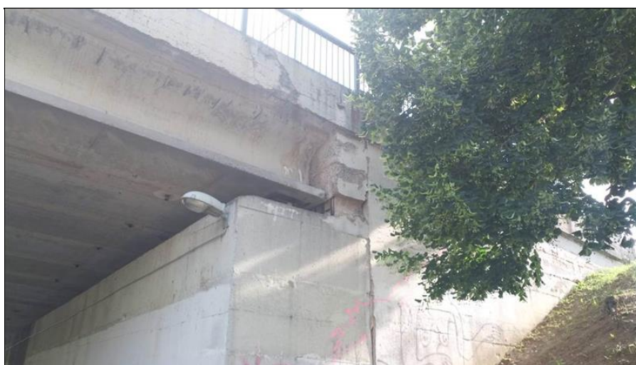
08-Degradace částí opěr - nekvalitní beton drolení betonu.jpg
