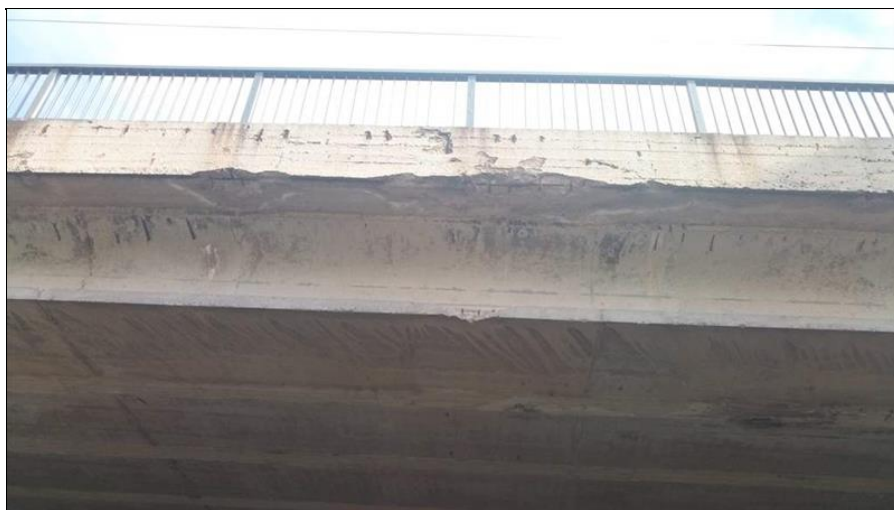
13-Degradace říms a krajních nosníků.jpg
