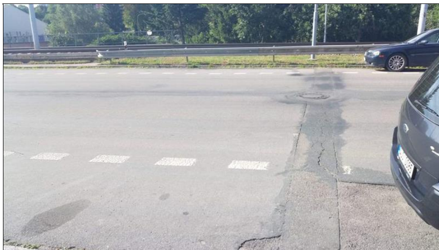
21-Oprava překopu před mostem trhliny ve vozovce.jpg
