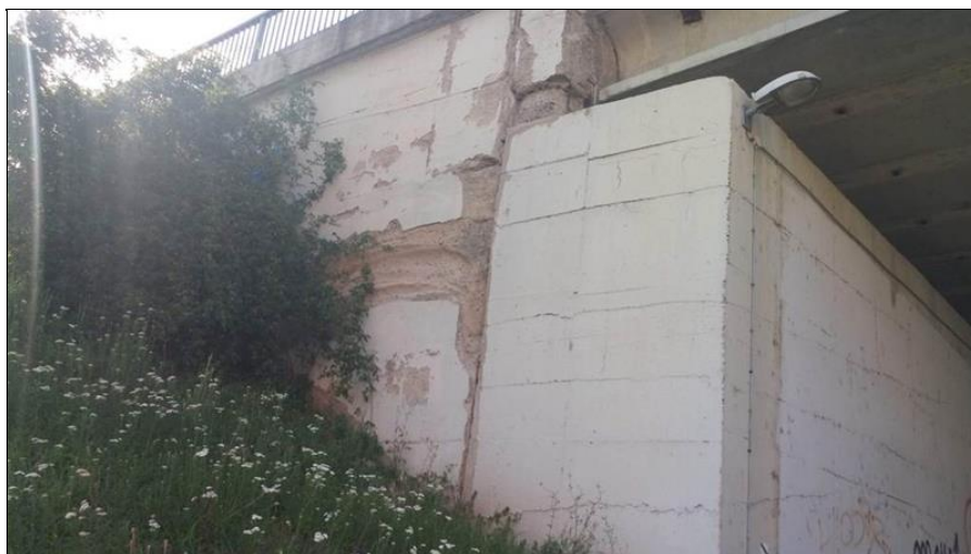
07-Degradace křídla - otěr povrchu vegetací.jpg
