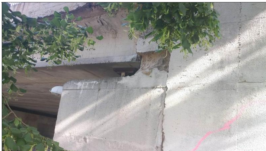
09-Pohled na závěrnou zídku u OP2 hloubkový rozpad betonu.jpg
